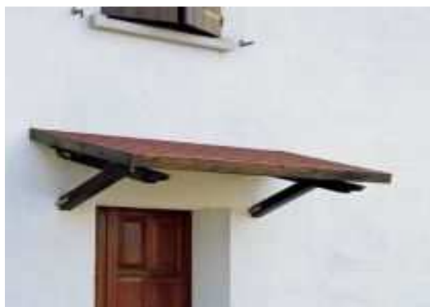
pensilina con copertura in legno
