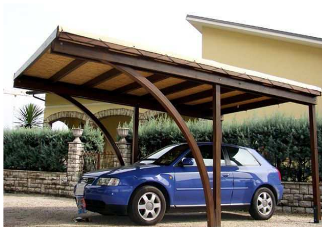
struttura "car port"
